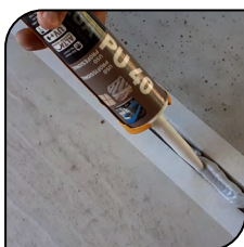
Junta de Dilatación
