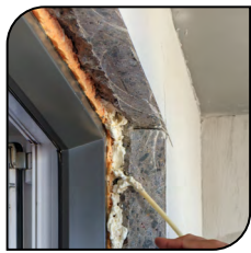
Instalación de puertas y ventanas
